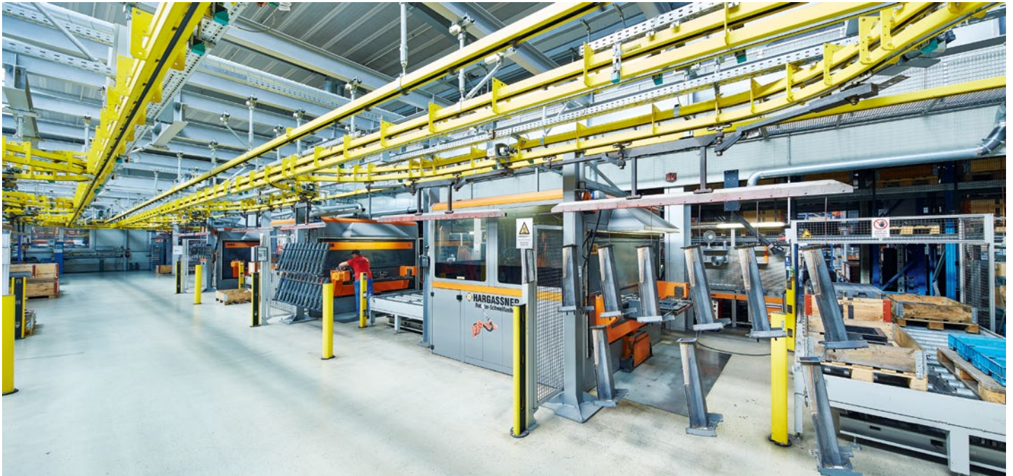
In der ersten Ebene befinden sich manuelle Aufgabestationen sowie ein durch 16 Roboter automatisierter Schweißprozess. Über die Förderanlage ist dieser erste Produktionsschritt mit allen weiteren Fertigungsstufen und -stationen verbunden.
