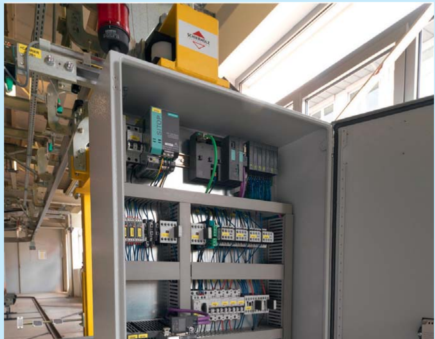
③ „Industrial Wireless LAN“-Performance mit Rapid Roaming: Dual Access Point Scalance W788-2 RR (blau markiert), Client Modul Scalance W747-1 RR (rot), RCoax-Leckwellenleiter (grün) und omnidirektionale Antenne ANT793-4MN (gelb) für schnellen, berührungslosen Datenaustausch zwischen Fahrwagen, zentraler Steuerung und Lagerverwaltungsrechner
